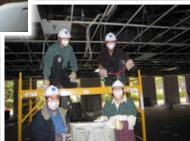
▲ 自10/6起連續五個週六，弟兄姊妹一起拆除A棟建築的天花板、日光燈等，以節省人力及材料花費。
